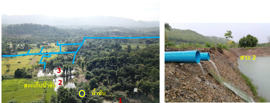
ภาพที่ 1 สระเก็บกักน้ำซับ ศูนย์เรียนรู้ฮอมนบุญอุศโต จังหวัดแพร่ ภาพที่ 2 ท่อระบายน้ำล้นจากสระ 1 มาสระ 2 ที่มา : อำนวย คลีโป, 2562
